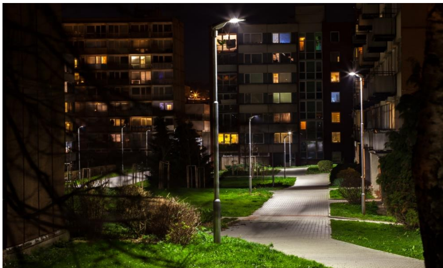
Obrázek 16 Soustava veřejného osvětlení s LED omezuje vyzářování světelného toku do horního poloprostoru, minimalizuje dopady rušivého světla (zřetelné u stožárů v pozadí fotografie) (foto: ETNA s.r.o.)
