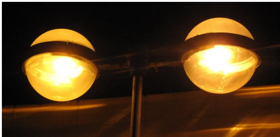
Obrázek 10 Rušivé světlo z necloněného svítidla s vyzařováním světelného toku do horní poloroviny (foto Theodor Terrich)
