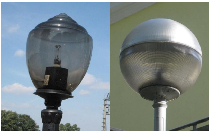
Obrázek 12 Příklad novodobých svítidel. Vlevo zcela nevyhovující svítidlo z hlediska rozložení vyzařovaného světelného toku. Vpravo svítidlo se cloněnou horní polovinou a prismatickým difuzorem (foto: Theodor Terrich)
