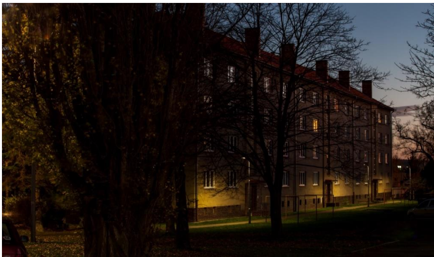
Obrázek 15 Moderní osvětlovací soustava VO s LED svítidly minimalizuje světelný přesah. (foto: ETNA s.r.o.)
