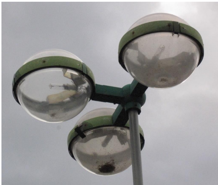
Obrázek 11 Typický příklad necloněného svítidla s prakticky žádným optickým systémem. Světelný tok je vyzařován všemi směry včetně horní poloviny (foto: Theodor Terrich)
